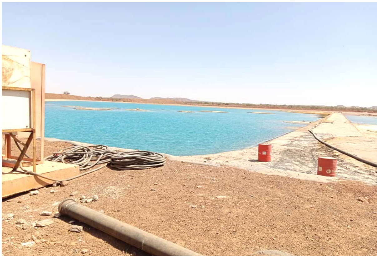
Site de traitement des déchets de la mine de zinc de Perkoa : Parc à résidus
